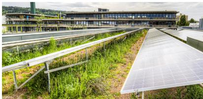
Kombination von Solaranlagen und Dachbegrünung (ewz-Unterwerk Oerlikon, Quelle: ewz)
