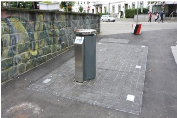
Abbildung 9: Presscontainer versenkt
