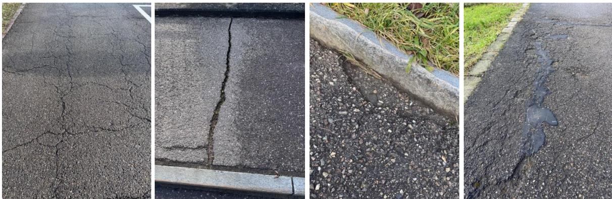
(Fotos Strassenzustand (Risse, Belagsschäden) Kastellstrasse)
