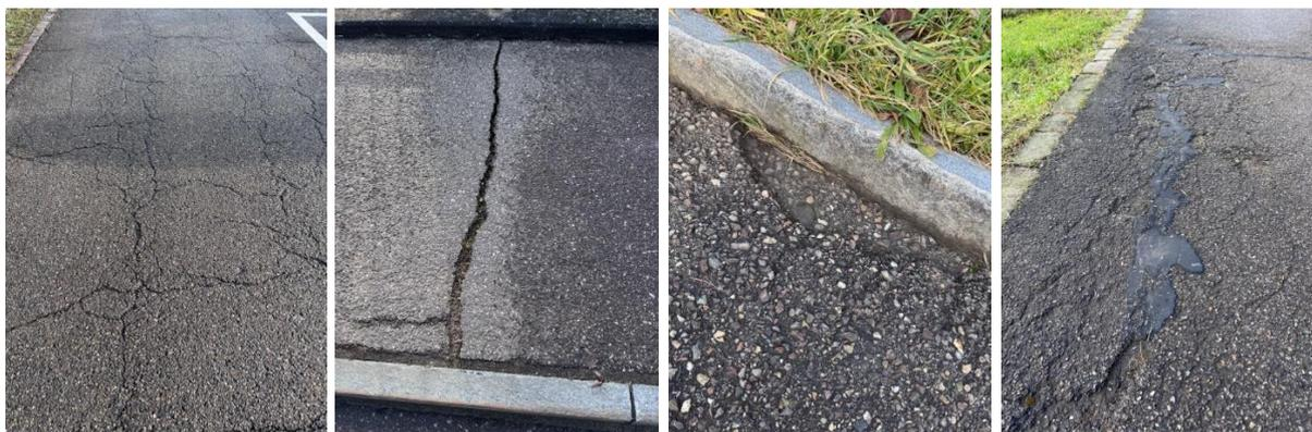
(Fotos Strassenzustand (Risse, Belagsschäden) Kastellstrasse)
